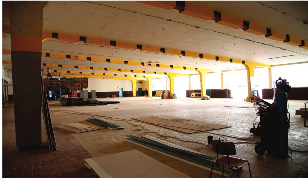
Eine Veranstaltungshalle für bis zu 850 Besucher entsteht derzeit in der Linzer Tabakfabrik. Foto: Tabakfabrik Linz
