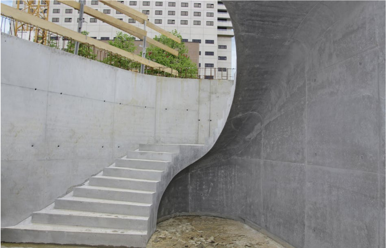
3D-Druck von Schalung: Pilotprojekt von Doka und voxeljet im Rahmen des Projekts “Neubau Sächsische Aufbaubank (SAB), Leipzig”; Credits: doka
