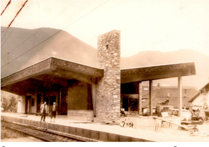
ÖBB Hst. Landungsplatz, 1971, Errichtung Neubau © ÖBB Archiv
