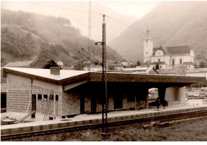
ÖBB Hst. Landungsplatz, 1971, Errichtung Neubau © ÖBB Archiv
