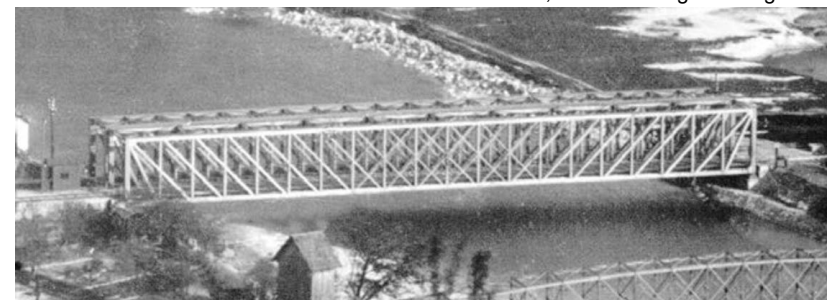
Schleppbahnbrücke Ebensee 1895, Internet, Salzkammergutzeitung
